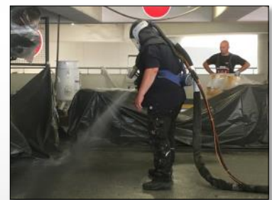
... und direkt folgend Verschleißschicht bei gleichzeitigem Einschleiben des Spezialhartstoffes
